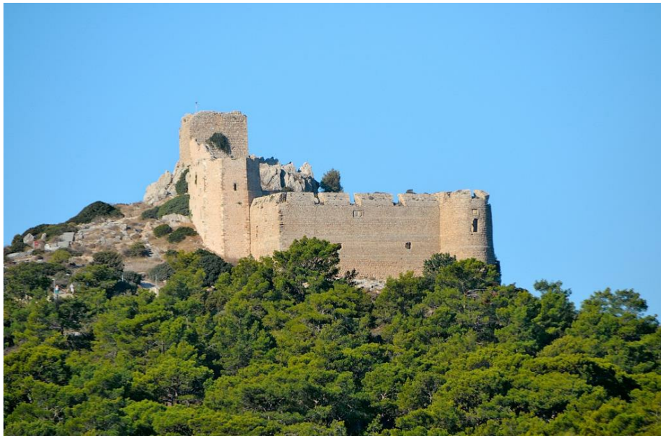
Auf einem schroffen Felsen über der Küste liegen die gut erhaltenen und restaurierten Reste der Johanniterburg, die Kastéllos genannt wird
