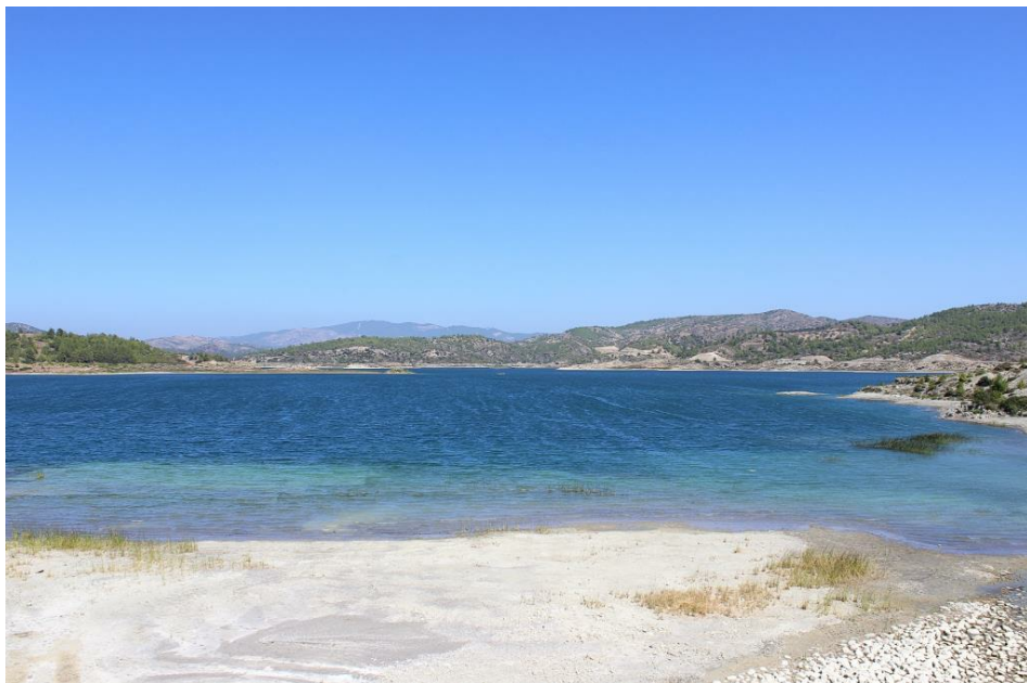
Der Gadoura Dam in der Nähe von Lárdos
