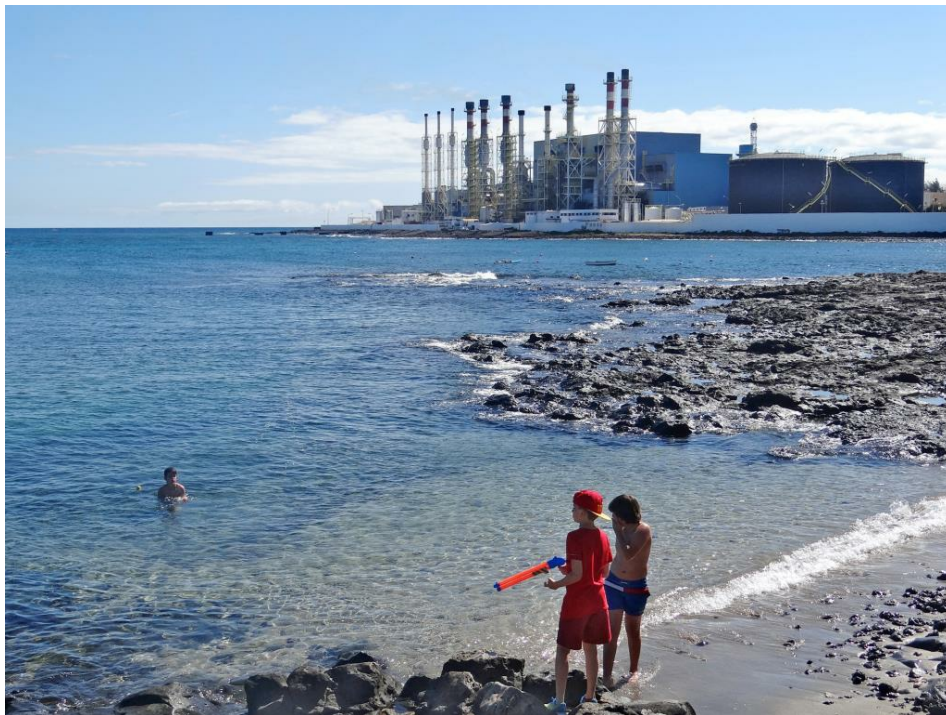
Die Entsalzungsanlage nördlich von Arrecife
