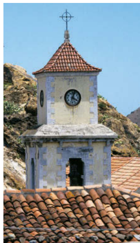
Der Turm der Pfarrkirche von Vallehermoso überragt die Dächer der Stadt.
